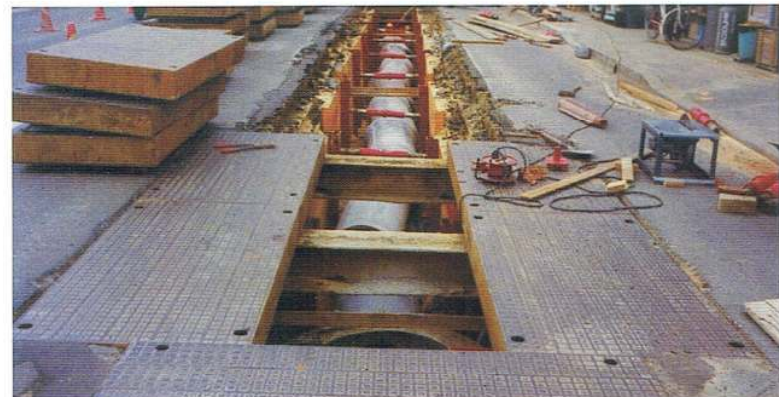
▲覆工板使用による設置（解説：P20）
