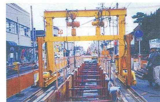
▲専用引抜機設置
