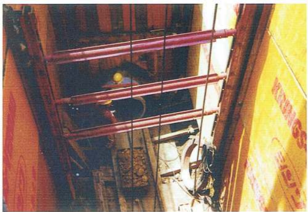
▲推進工事の竖孔
