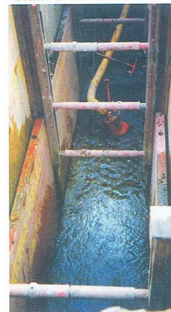
▼多量湧水地盤における DG 型 (深掘り用) 設置 (解説: P10)
