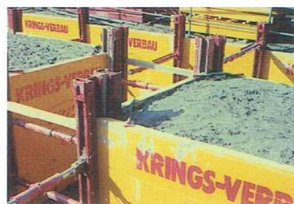
▲井形の土留め
