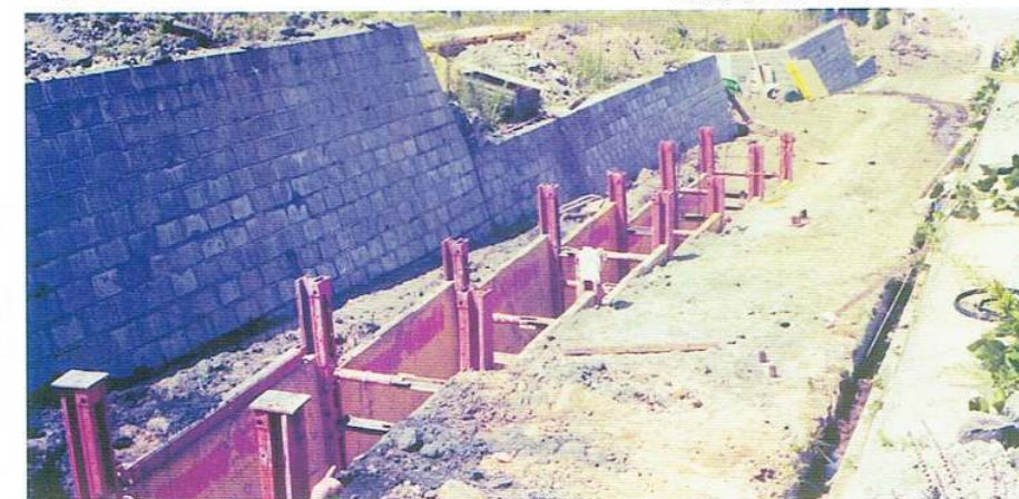
▲傾斜地における階段状土留め
