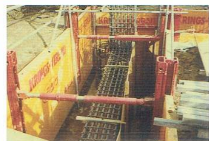
▲コーナー部の施工
