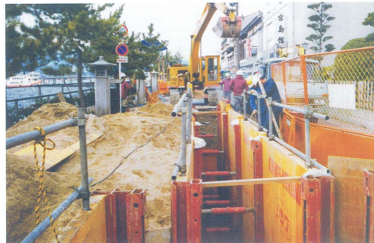
▲海に面した道路での施工 (人孔部と管路部の接続) (解説: P17)
